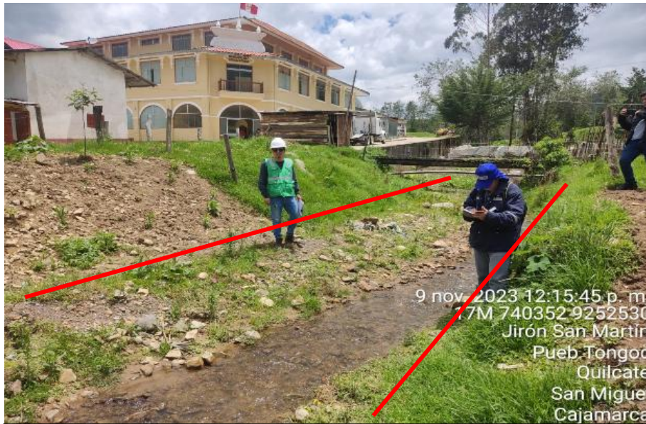
IMAGEN N° 01: VISTA DE TRAMO CON AMBOS MARGENES VULNERABLES DE LA QUEBRADA QUITAHUASI EXPUESTOS ANTE CRECIDA DE CAUDAL DE LA QUEBRADA
